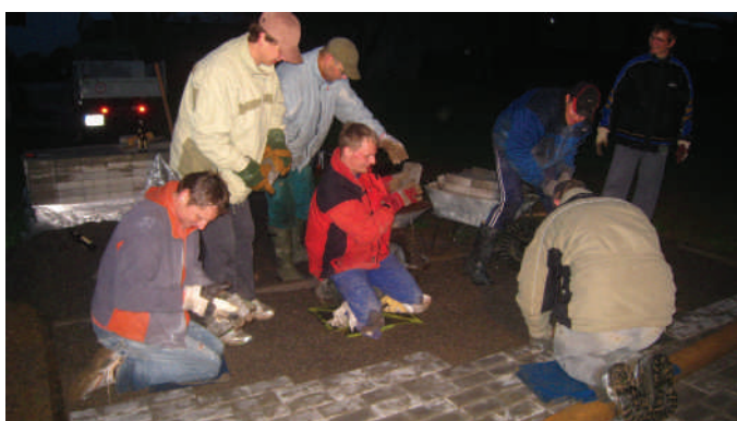
Ani nízké teploty, déšť a tma nezabránilly dokončit pokládku nové dlažby pod základnou.
